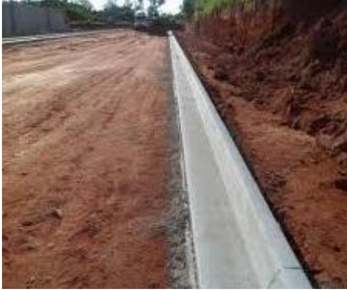
Sarjeta e meio fio em aterro
