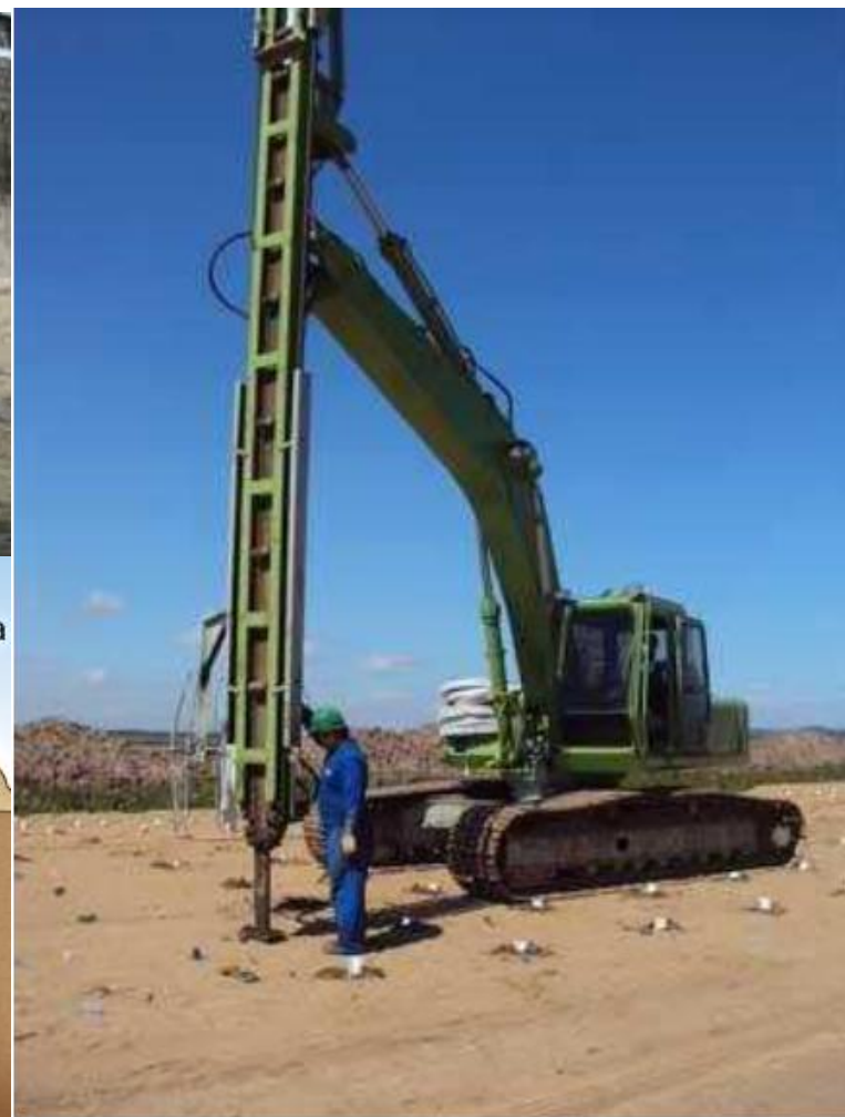
Instalação dos Geodrenos
