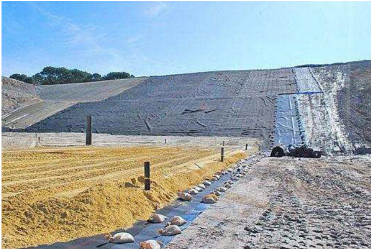
Geossintético aplicado como sobre a superfície do terreno
